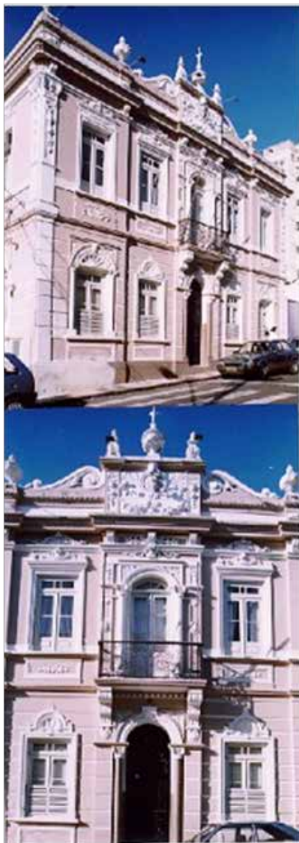
Prédio da Fundação Visconde de Cairu após reforma.
