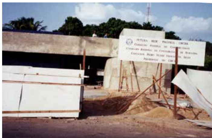
Figura 7 – Obras da Sede Própria do CRCRR
