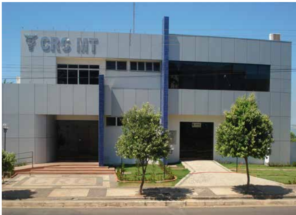
Foto nº 15 - Prédio atual do CRCMT.
