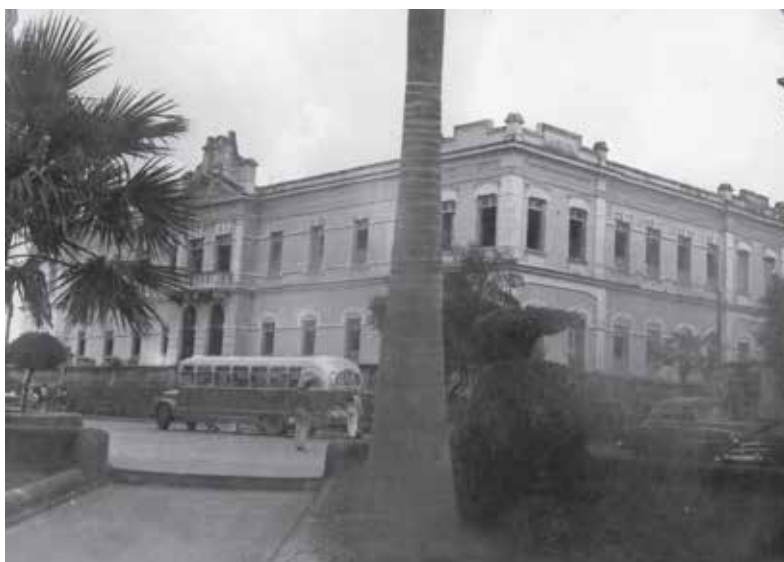
Foto nº 1 - Prédio onde funcionava a Escola Técnica de Comércio de Cuiabá, no qual o Contador Aecim Tocantins iniciou a sua atuação no Magistério.
