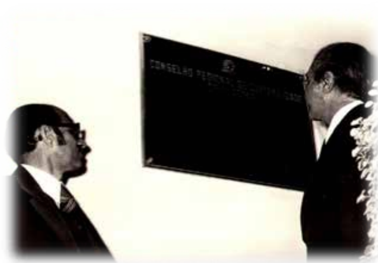
Fig 32 - Descerramento da placa de inauguração da reconstrução da sede
