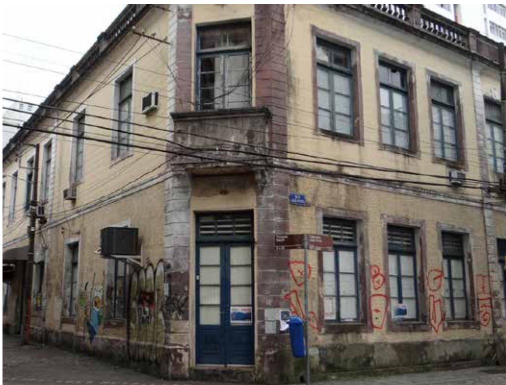
Figura 4 - Prédio onde foi fundado o Instituto Polytechnico de Florianópolis (1917)
