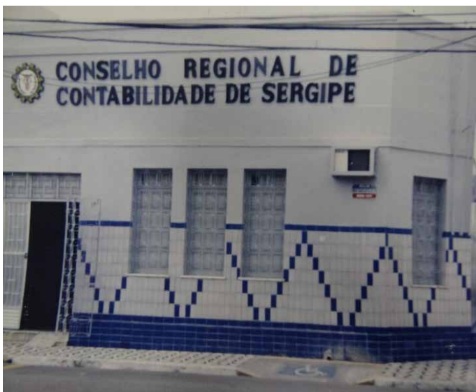
Figura 16 - 3ª sede reformada – Rua Itaporanga
